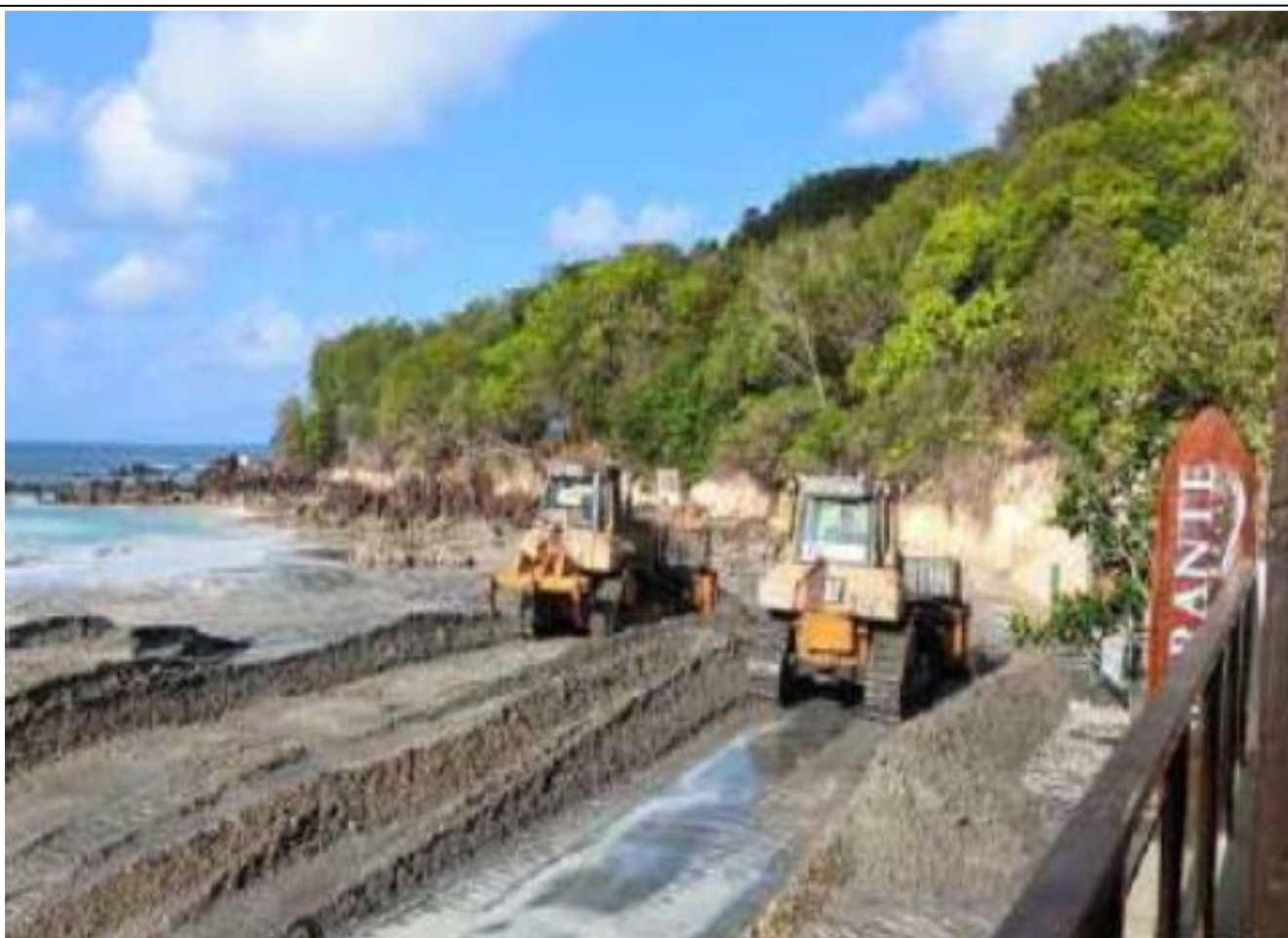
Foto 5 - Engorda, Morro do Careca (Supervisora GCA, 22/1/2025)
