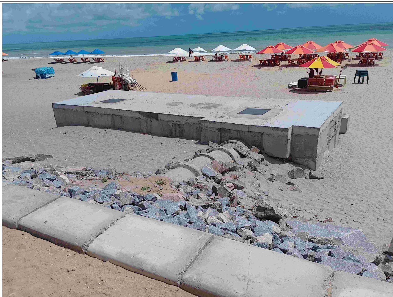
Foto 7 - Dissipador de Energia (Drenagem Pluvial, 4/11/2025)
