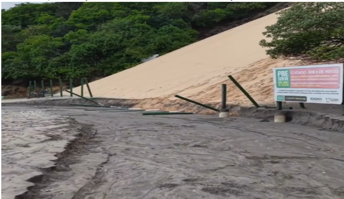
Foto 3: Nova voçoroca aberta junto ao Morro do Careca, com derrubada da cerca protetiva e efeito erosivo na base da duna
