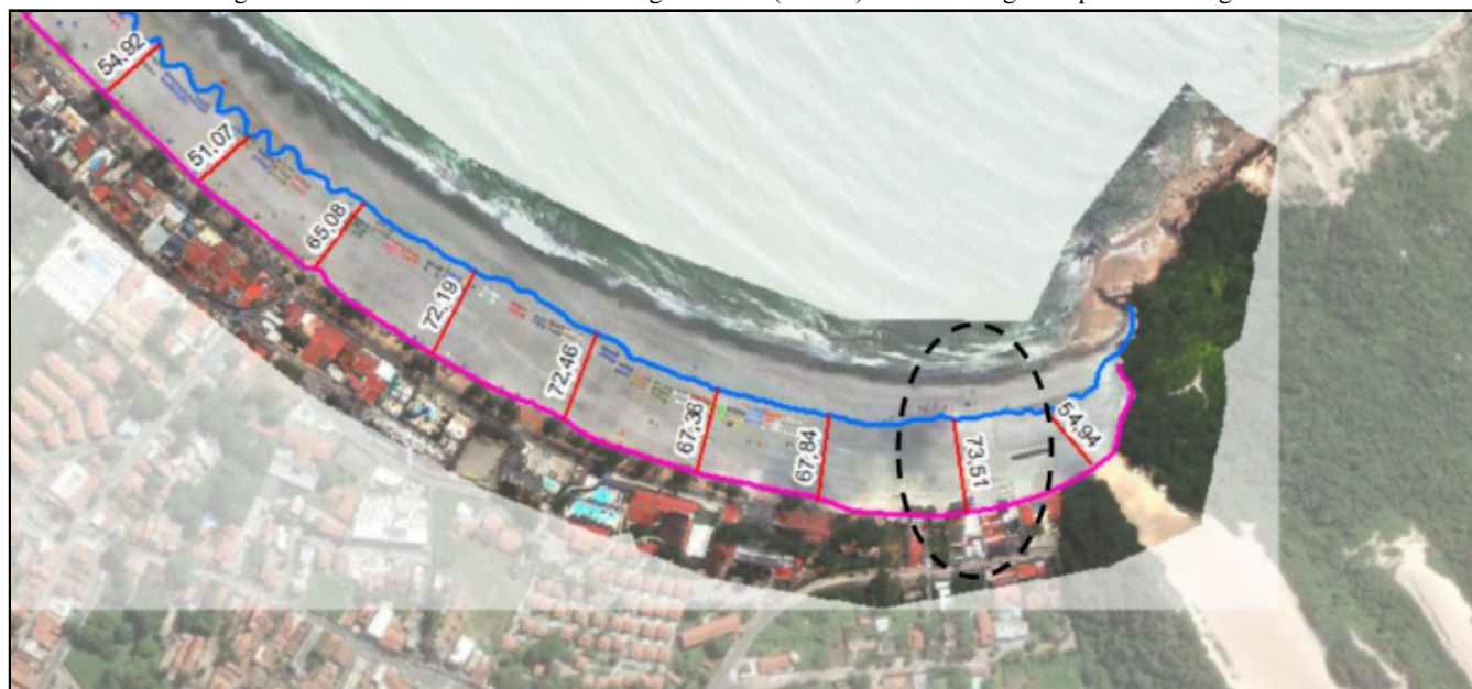
Figura 7: Detalhes da faixa de areia no segmento sul (zona C) com suas larguras após a obra engorda
